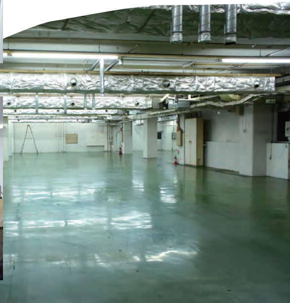
工場内ラインが撤去された 5 階フロア。
